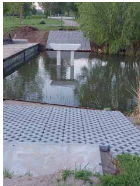
De pijler voor de twee brughelften is klaar.
