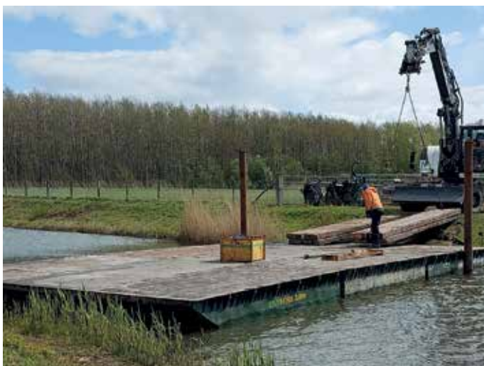
Er is een ponton geplaatst waar de kraanwagen op kan rijden.
