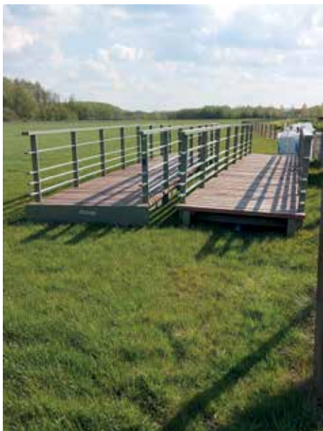
De twee brugdelen van het bruggetje liggen klaar.
