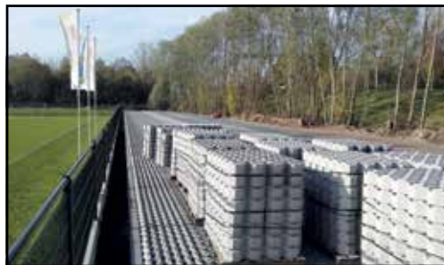
Parkeerterrein in aanleg tussen Sportpark en Lange Akkers
