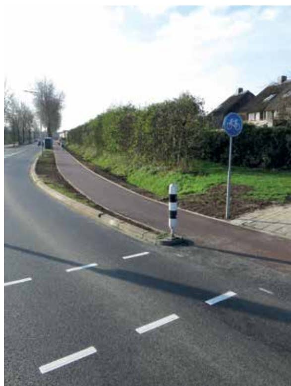
Betegeling van het fietspad aan beide zijden vervangen door rood asfalt
